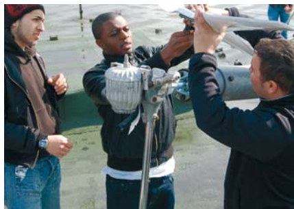
Schüler der Gewerbeschule 17 montieren die selbst konstruierte, kippbare Mastkonstruktion und die Rotorblätter des neuen Windrads. Foto: Norbert Brinkmann
