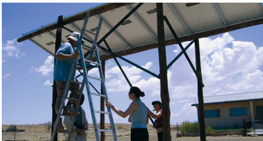
Die Heinrich-Hertz-Schule packt an: Bau einer Photovoltaik-Anlage an der Nabasib Primary School in Namibia. Foto: Wolfgang Thiel
