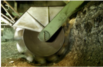
Kompostwender in der Rottehalle (Quelle: Homepage des Kompostwerkes)
